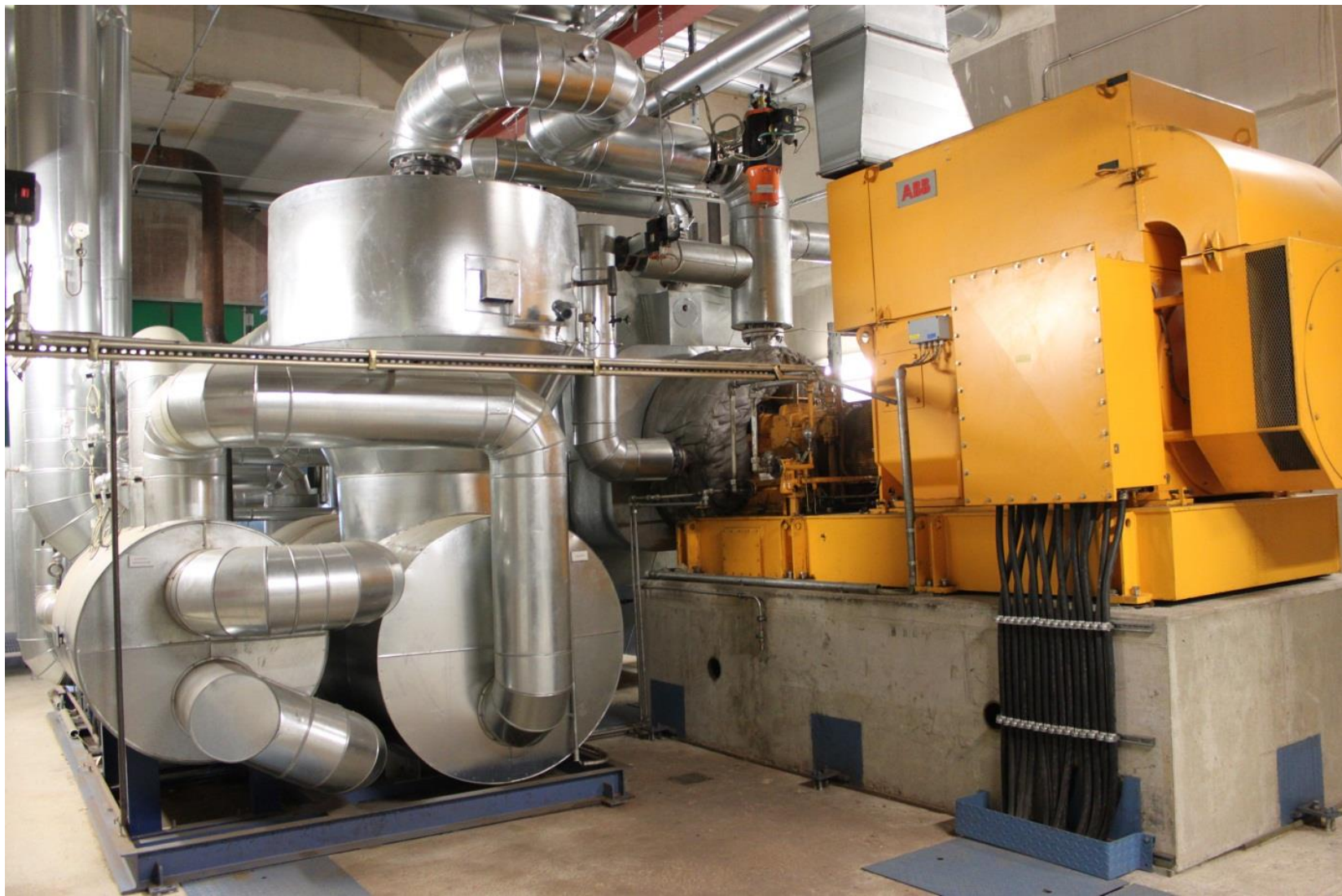
Σύστημα ORC (1,520 kW el ) της 'Grünfuttertrocknungsgenossenschaft Kirchdorf a.H.eG' (Πηγή: Rutz D.)
